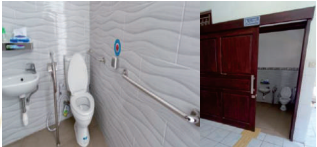
Gambar : Toilet disabilitas pada Pengadilan Negeri Singaraja
